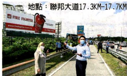
■峇鲁希山 (右) 与诺莱妮巡视广告牌拆除工程。
